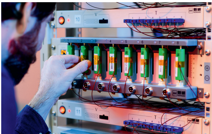
Bild 2: Die TwaiCE-Batterielabore erzeugen schnell Testdaten und kalibrieren die eigene Software auf das elektrische, thermische und das Alterungsverhalten von Batterien. © TwaiCE
